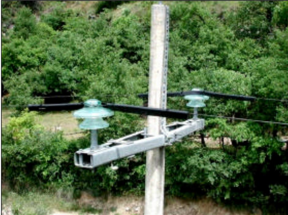
**Figura 14** - Esempi di applicazione dei profili in gomma sui conduttori e isolatori in tensione (Foto: ENEL).
